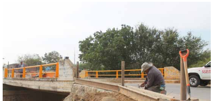
Construcción de machuelos y banquetas en área peatonal de el puente de la Candelaria.
